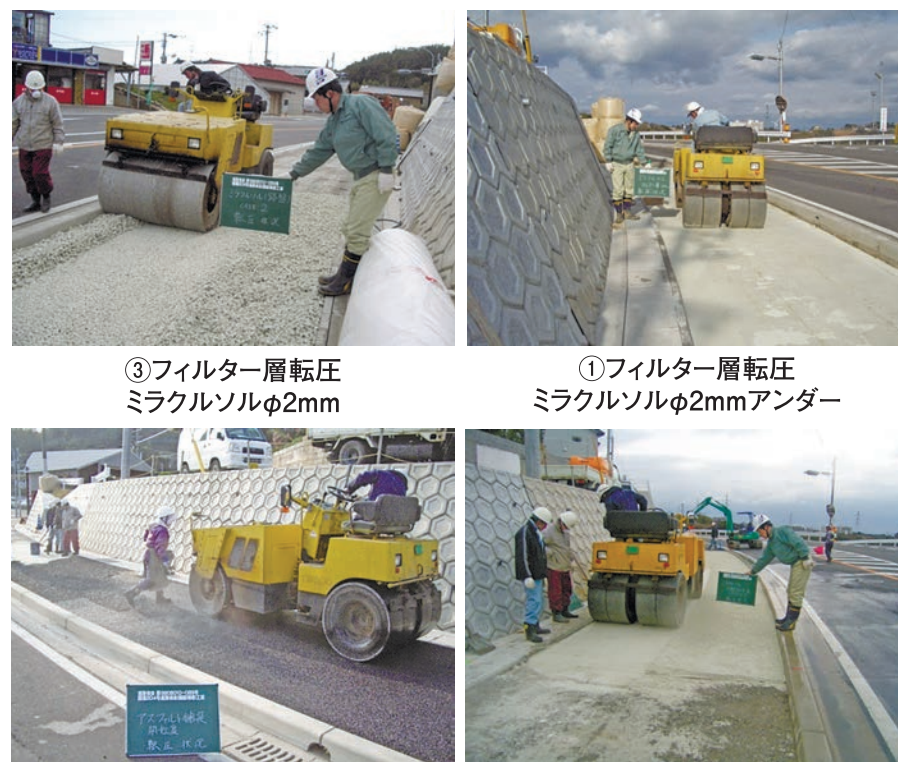
写真一1 FWG透保水性舗装工法の工程
