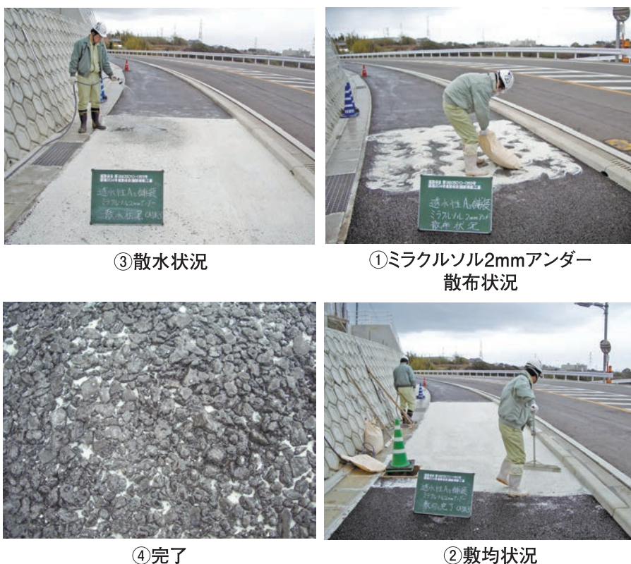
写真一2 アスファルト空隙への2mmアンダー間詰め材の工程
