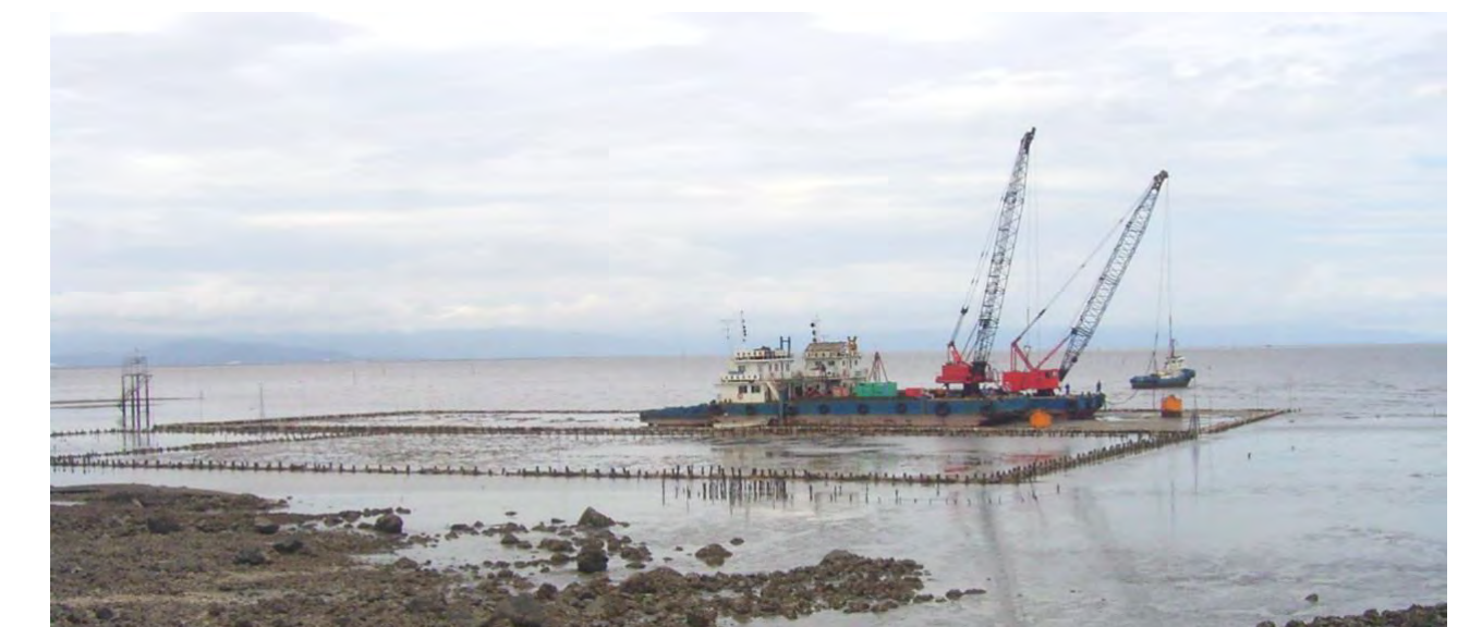
図7 底質改善区の構築状況
