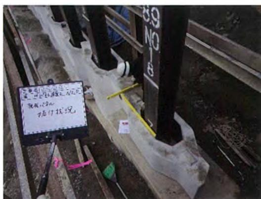
写真.5 親杭パネル据付状況
