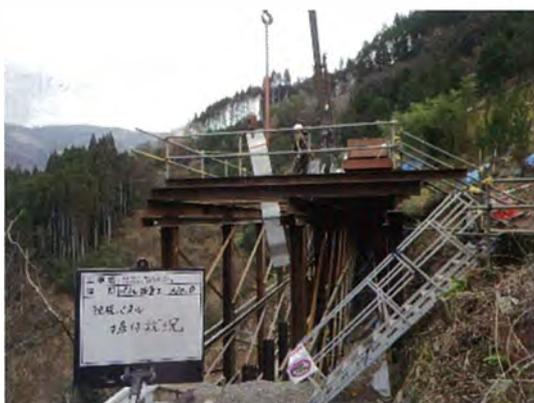
写真.4 親杭パネル吊込状況
