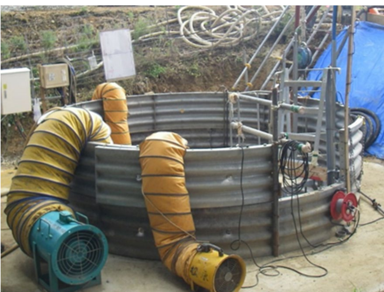
集水井施工状況
